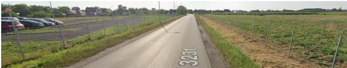
9. ábra A 3231 sz. út a vasút felé
